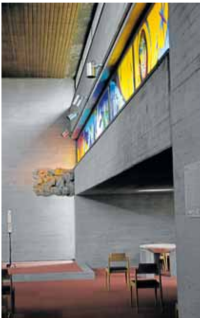
Das Fensterband befindet sich an der Nordseite oberhalb der Taufschale.
